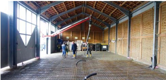
Der Boden in der Halle des Altstoffsammelhofes wurde im Oktober saniert. Der Pflasterboden aus dem Jahre 1997 hat den Belastungen der Containerab- und -anlieferung nicht mehr standgehalten und wurde durch eine monolithische Bodenplatte mit Hartkorneinstreuung ersetzt. Weiters wird eine vom Bauhof hergestellte Stahlführung zum Abstellen der Container montiert. ■
